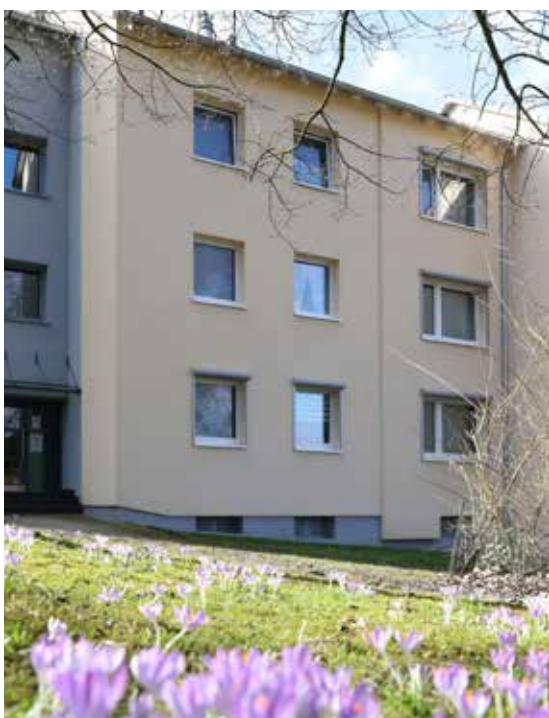
▲ Umfassend saniert: Siedlung Brühler Berg
