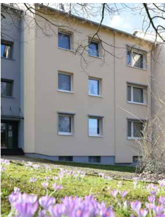
▲ Umfassend saniert: Siedlung Brühler Berg
