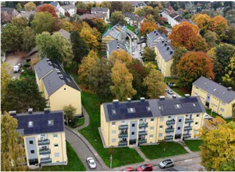
▲ Die Siedlung Hoffeld: In sechs Bauabschnitten werden über 50 Häuser modernisiert
