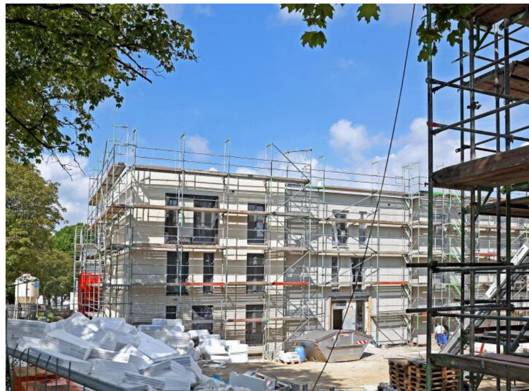
Der Wohnkomplex Böckerhof am Argonner Weg nimmt zunehmend Gestalt an.
