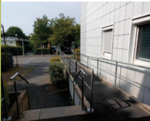
▲ Barrierefreie Zuwegung an der Hasselstraße
