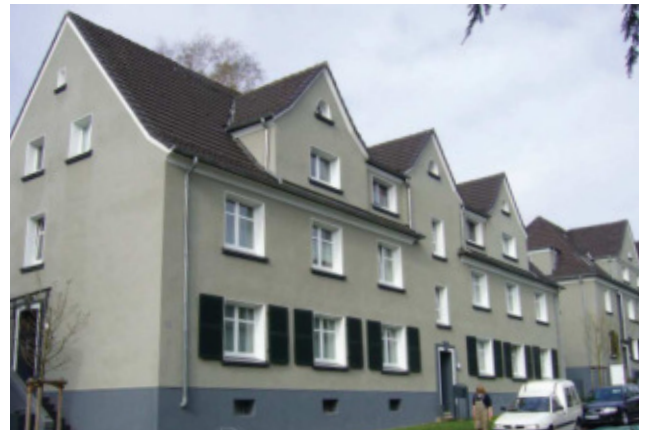
▲ Hermann-Meyer-Straße vor / nach der Sanierung
