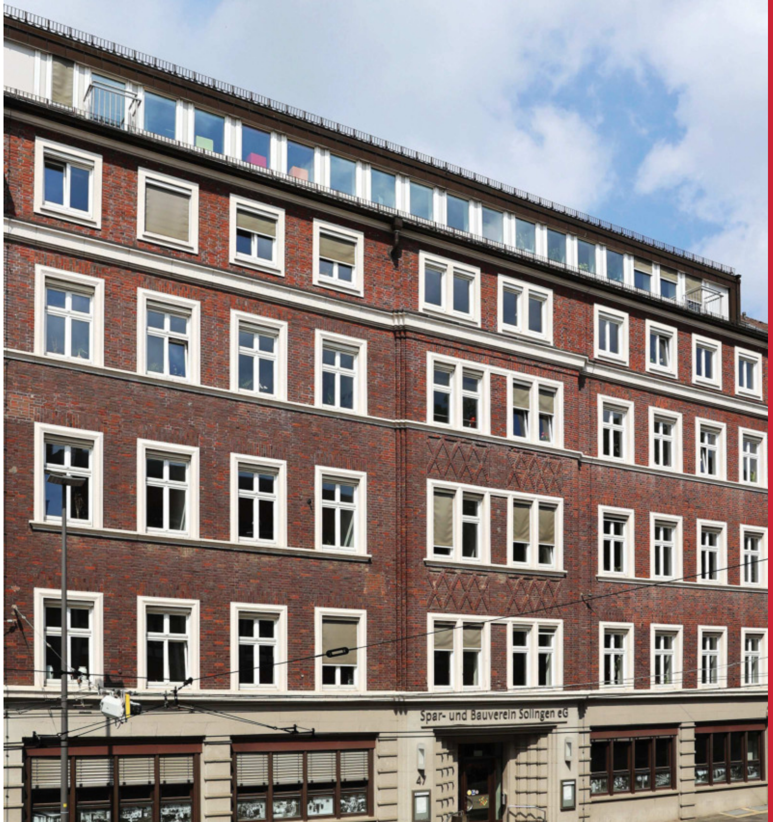
▲ Das denkmalgeschützte Verwaltungsgebäude wurde zwischen 1999 und 2001 umfassend saniert
