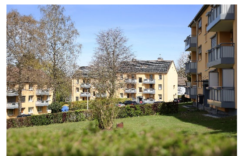
Abseits vom Durchgangsverkehr
