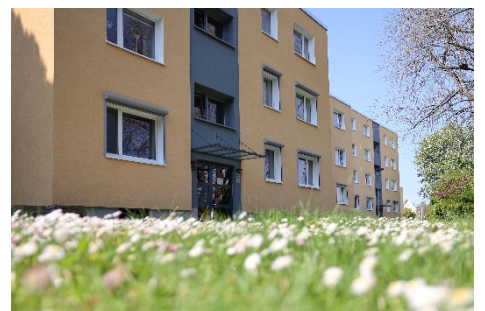
Hochwertige Fassaden durch Modernisierung
