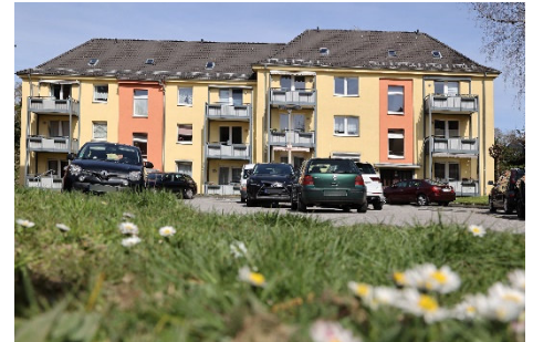
Siedlung Glockenstraße: schön dank Modernisierung
