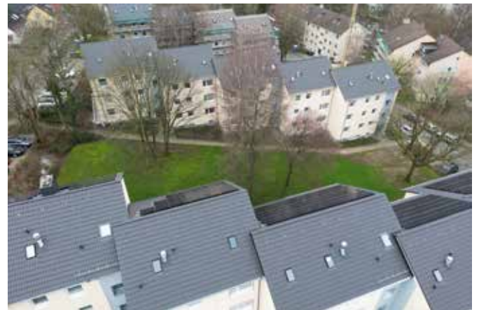
▲ PV-Anlagen auf den Dächern am Brühler Berg
