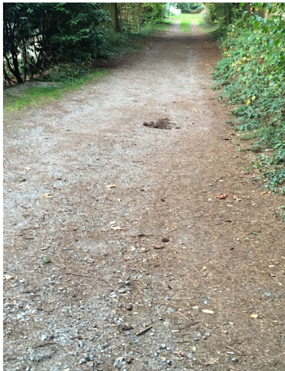
▲ Auf dem Bahndamm liegt bis heute teilweise noch der alte Gleisschotter.
